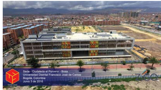
Avance de obra sede Ciudadela El Porvenir – Bosa. Junio de 2016. Fuente: Consorcio UniDistrital.
