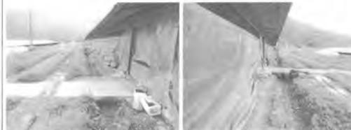
En la Avícola Polo Olímpico ubicada en la parte alta de la vía al llano, se hace manejo de aguas lluvias de los galpones mediante zanjas en tierra con descoles controlados no perjudiciales en los taludes.
