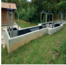
Canal de entrada
