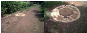
Foto: La auditoría estuvo presente en obras ejecutadas en Robles, Guachinte y Timba.
