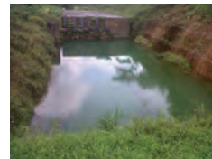
Tanque de almacenamiento de Venecia – Obra sin terminar, financiada con recursos del FNR.
