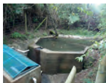
Bocatoma y desarenador
