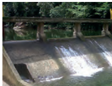
Fuente hídrica Río Escalarete, obras de captación
