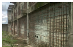
Obra con un avance del 15%, fecha de inicio de obra el 31/10/2011, con un plazo inicial de 4 meses.
