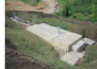
Canal de entrada
