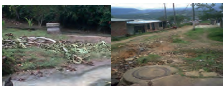
Alcantarillado de Florencia: Disposición directa de aguas residuales, sin tratamiento.
