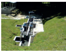
Canal de entrada
