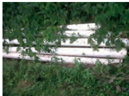
Tubería y tanque de almacenamiento Del acueducto Inconcluso de Pavarandó.
