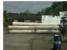
El objeto de este contrato es la terminación de instalación de tubería de 27", fecha de inicio 7/10/2011, con un plazo de ocho meses. El grado de avance en inversión es del 22%.
