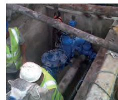
Obras de microsectorización
