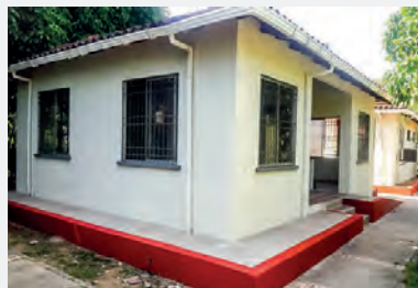
Foto 7. Remodelación sede judicial de Inírida
