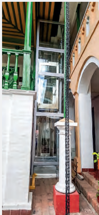
Foto 6. Instalación de elevador en el Palacio de Justicia Manuel Antonio Sanclemente de Buga
