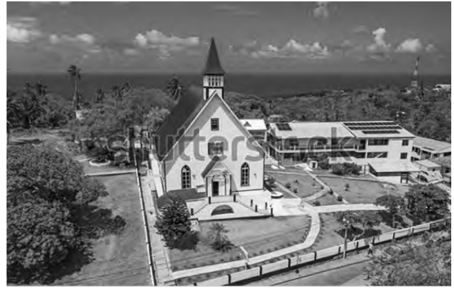
Primera Iglesia Bautista San Andrés Isla, fundada en 1848 y terminada de construir en 1896, mediante una técnica de sistema modular de piezas de madera importada de Alabama, EE.UU.
