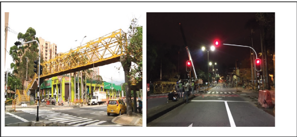
Retiro puente peatonal: Universidad de Antioquia.
