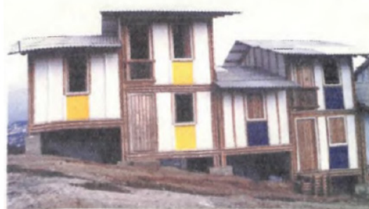
Imagen 2. Casas Urbanización La Divina Providencia. Tomado de: Construcción y Dirección de la "Urbanización la Divina Providencia" del Arquitecto Gilberto Flórez.
