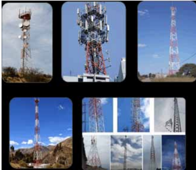
FIGURA 6-1. Estructuras de soporte tipo torres
