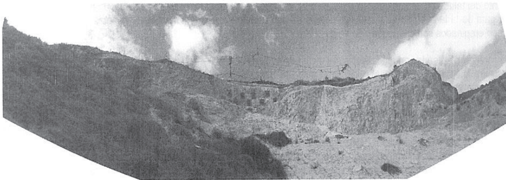
Foto 2. Panorámica del talud del barrio Brisas del Volador antes de la intervención tomada en febrero de 2008.
