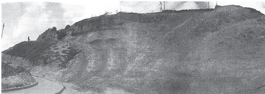
Foto 5. Aspecto del talud del Barrio Brisas del Volador después de ejecutadas las labores de excavación y retiro de material y conformación de terrazas, tomada en Abril de 2008.
