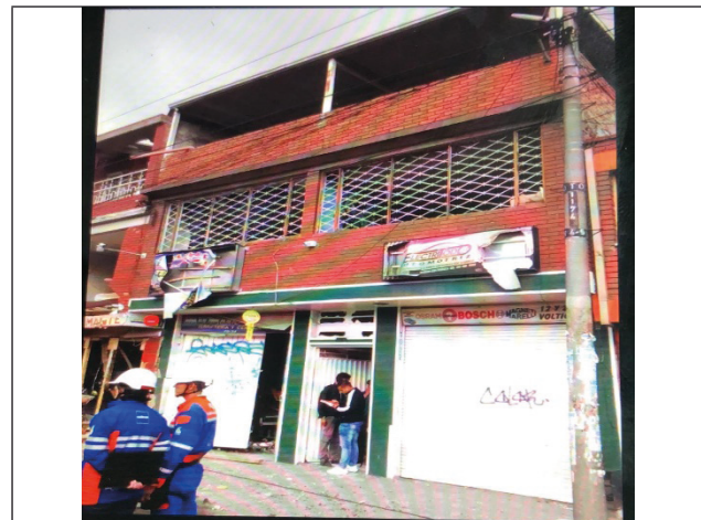
Fotografía 1. Fachada de la Av. Carrera 70 No 70 -36, en el Sector Catastral de la Estrada de la Localidad de Engativá.
