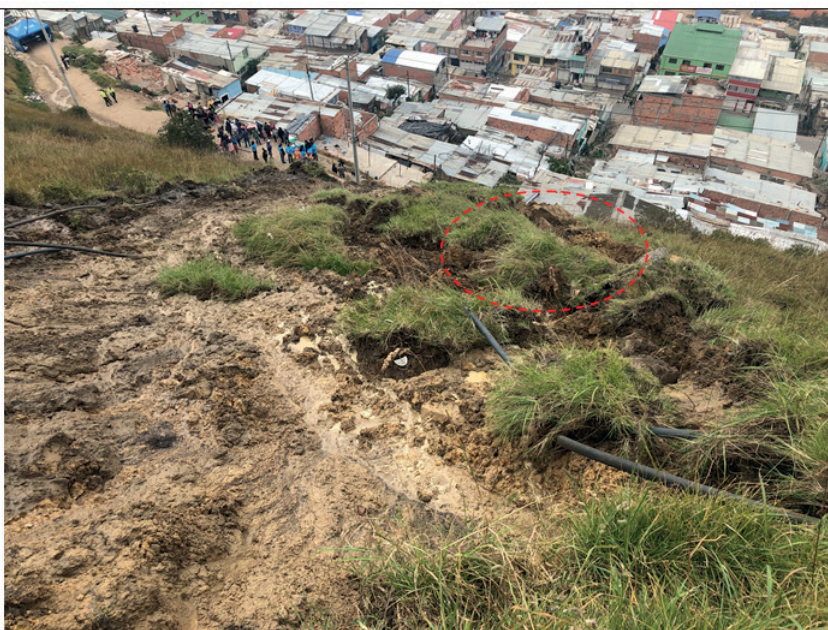
Fotografía 7. Bloques de roca localizados en la parte media de la ladera, en el Barrio Caracolí en la Localidad de Ciudad Bolívar.
