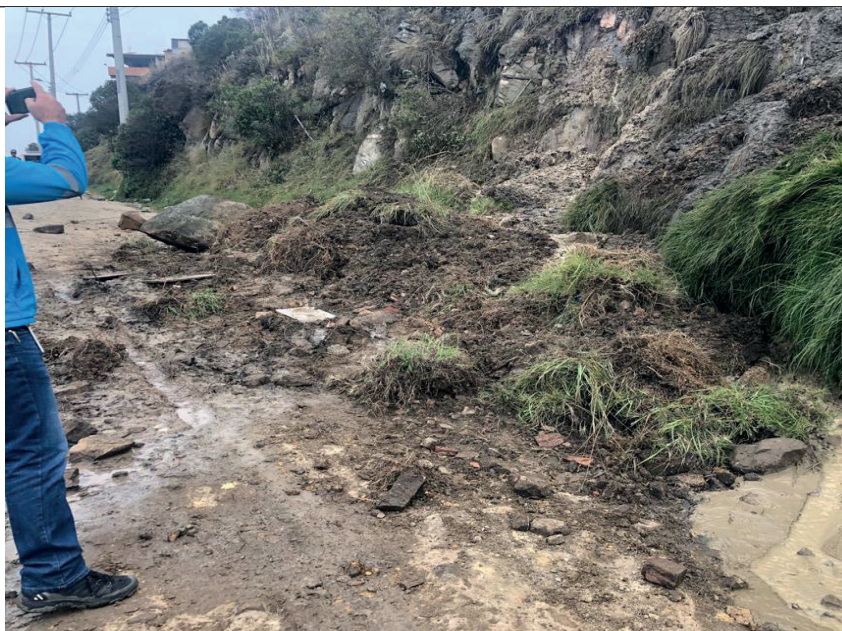
Fotografía 6. Vía localizada en la parte baja de la ladera en el Sector de la Calle 76 Bis Sur entre Carreras 73B y 73C, en el Barrio Caracolí en la Localidad de Ciudad Bolívar.
