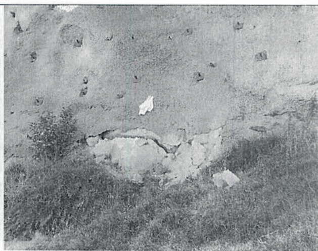
Fotografía 10. Vista de abertura de la discontinuidad localizados en la parte media del talud de corte.
