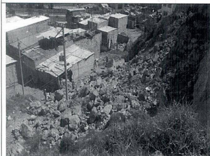
Fotografía 3. Desprendimiento de rocas en noviembre del 2017.
