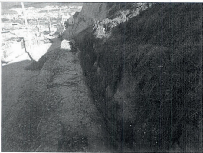
Fotografía 9. Vista de la cuneta localizada entre el talud y el muro en gaviones.
