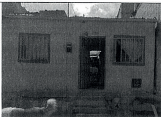
Fotografía 9. En el predio 1 no había daños en el exterior para Predio 1 en abril 2019.
