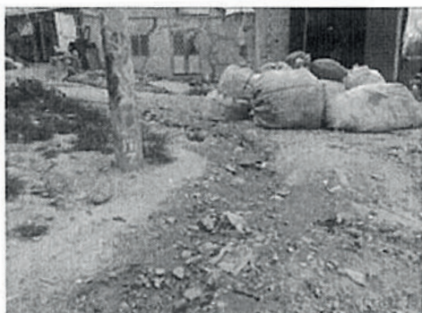
Fotografía 17. Filtraciones de agua provenientes de la parte alta de la ladera
