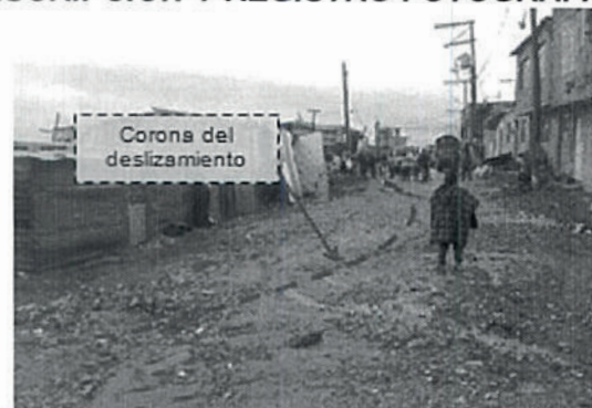
Fotografía 1. Grieta de tracción identificada en abril del 2019
