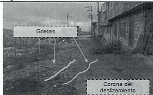
Fotografía 2. Grieta de tracción identificada en julio del 2019
