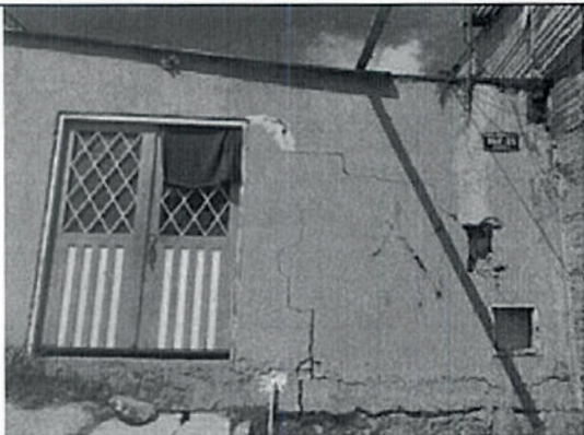
Fotografía 13. Vista desde el exterior del predio 5. Julio 2019
