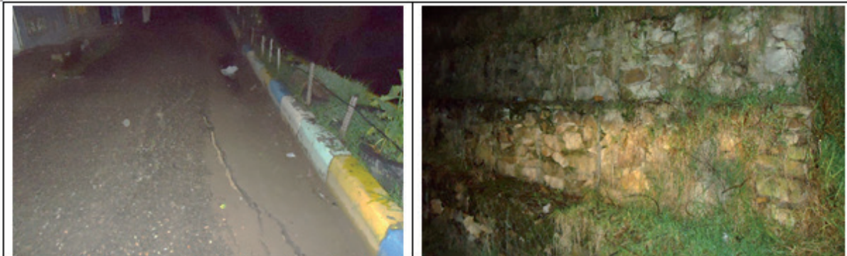
Fotografía 3. Hundimiento identificado en el costado occidental de la Carrera 4 Este – 20/11/2019
