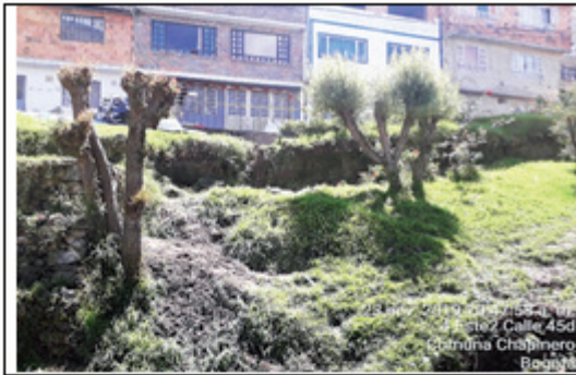
Fotografía 13. Deformación del sector y del sardinel de confinamiento – 23/11/2019
