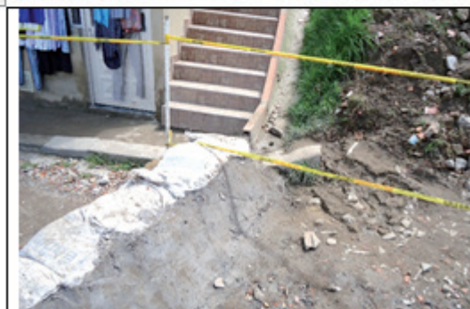
Fotografía 11. Obras temporales de canalización de aguas realizadas por la Comunidad del sector – 23/11/2019
