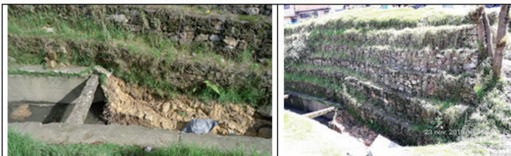
Fotografías 18 y 19. Desprendimiento de material en la margen izquierda del canal y del muro de gaviones – 26/11/2019
