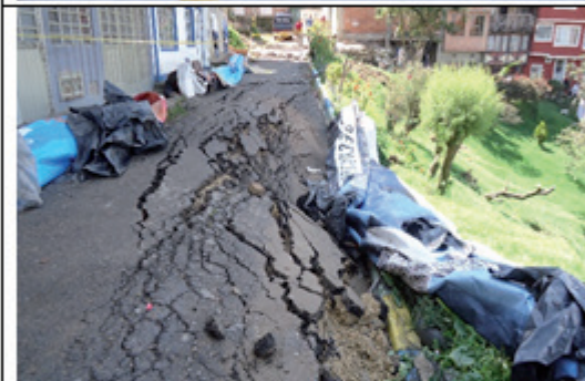
Fotografías 7 a 10. Aumento de los daños en la vía de la Carrera 4 Este, entre Calles 45C y 45D – 23/11/2019
