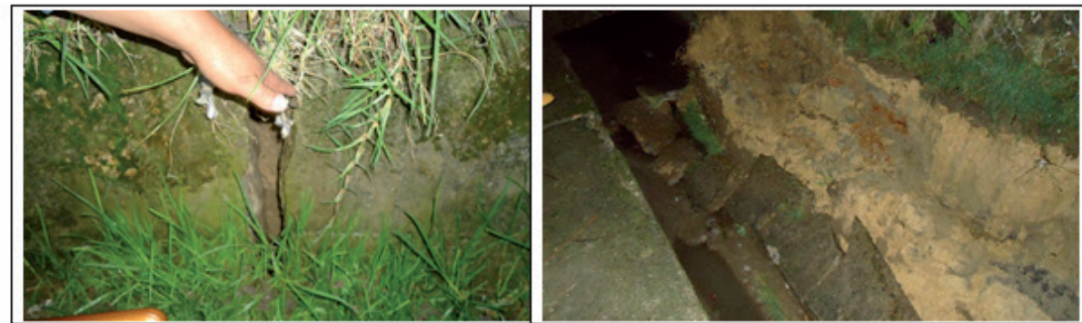
Fotografía 3. Hundimiento identificado en el costado occidental de la Carrera 4 Este – 20/11/2019
