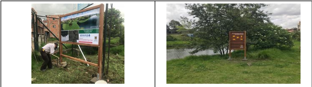
Ilustración 6: Instalación señaléticas tipo I y II sector norte del PEDH La Vaca
