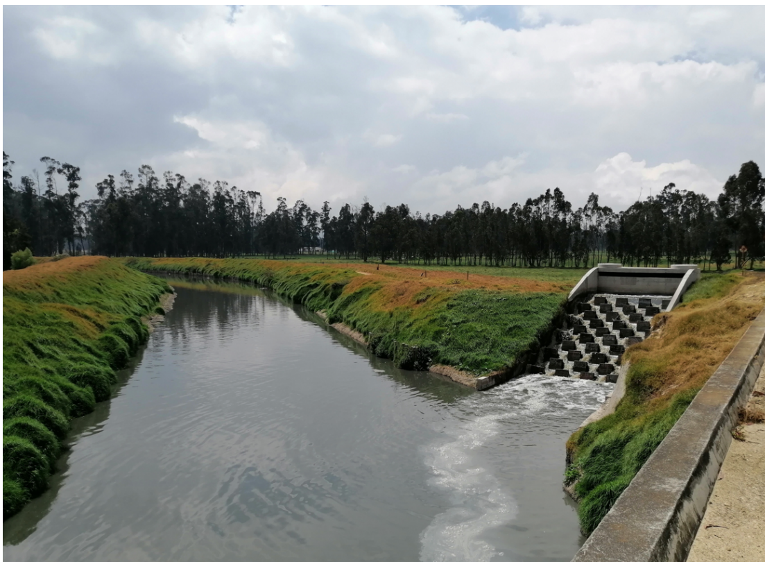
Efluente Estación de Bombeo Bosatama al río Tunjuelo Fuente: Grupo Recurso Hídrico Superficial, 2021.
