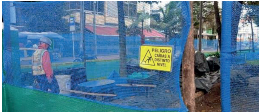
Señalización preventiva en obra. Fuente IDU
