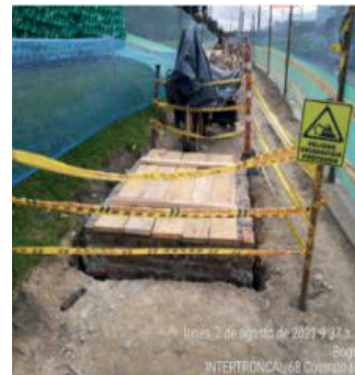
Señalización y Plafonado de pozos. Fuente IDU
