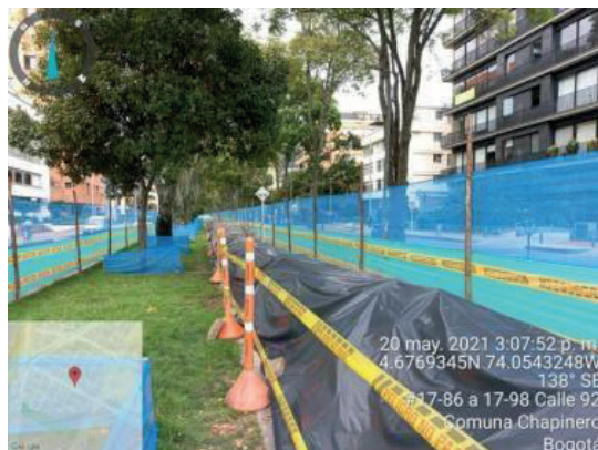
Manejo de Acopio de Materiales. Fuente IDU
