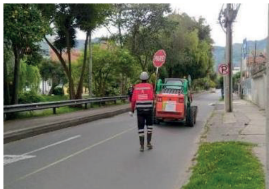
Circulación de Maquinaria y/o Equipos. Fuente IDU
