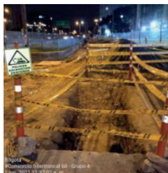
Señalización de Excavación Profunda. Fuente IDU
