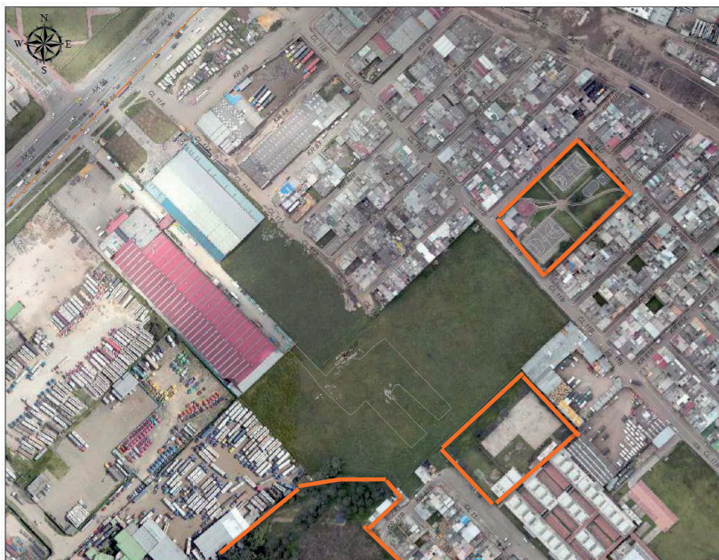
Localización Humedal de Techo y parques de la Unidad de Gestión UG-1 y del Desarrollo Santa Catalina Sector 1 y 2
