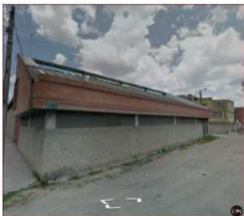
Imagen 9 Industria CL 11 A con KR 83 Occidente-Oriente costado Norte
