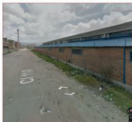
Imagen 8 Industria CL 11 A con KR 83 Occidente-Oriente costado Sur
