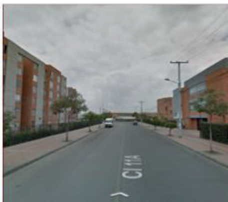
Imagen 24 Vivienda Multifamiliar Urb. Parques de Castilla 4 y 5 CL 11 A con KR 79 A Oriente-Occidente
