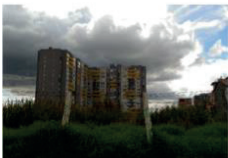
Imagen 31 Vivienda altura 13 a 15 pisos Vivienda Multifamiliar Urb. Plaza Castilla Cl 10 con Kr 80 D Oriente-Occidente costado Norte
