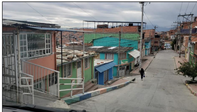
Ilustración 19 Tipología constructiva Sector Potosí vista 1
