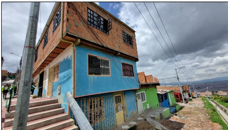
Ilustración 25 tipologías constructivas Tres Reyes vista 1
