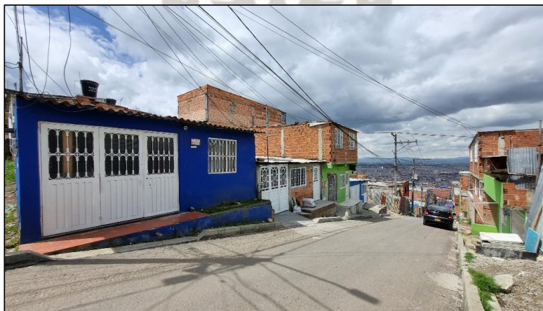
Ilustración 26 tipologías constructivas Tres Reyes vista 2
