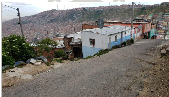
Ilustración 20: Tipología constructiva Sector Potosí vista 2
