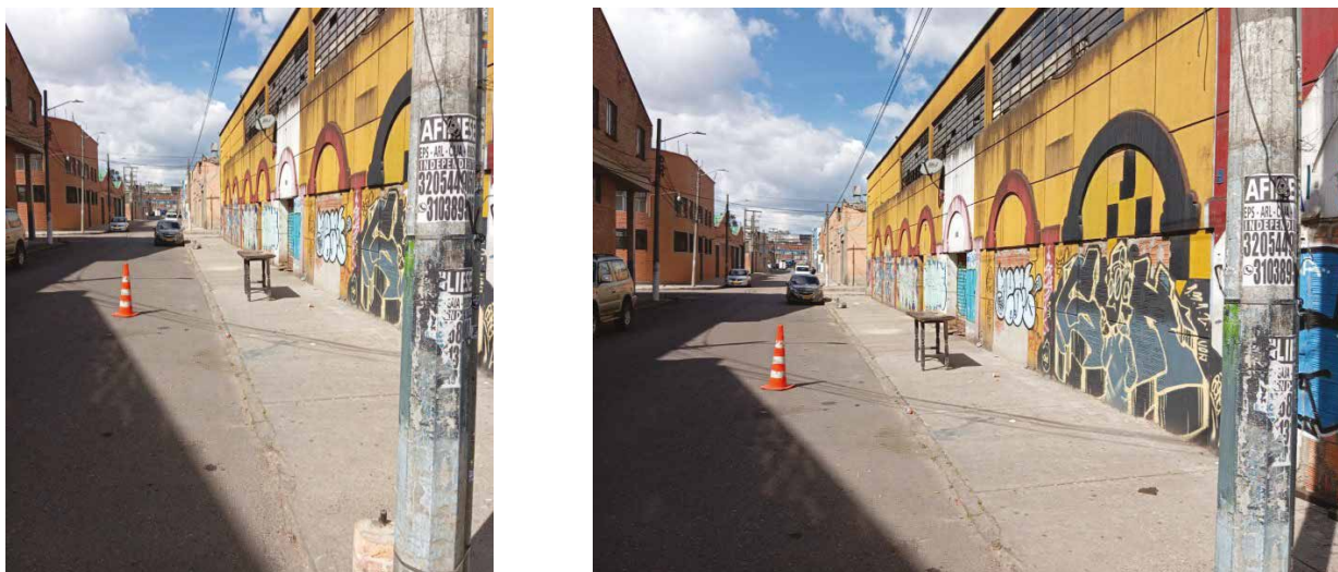
Ilustración 42 Estado del andén de la carrera 37 Fuente: Archivo Polaris Constructora
