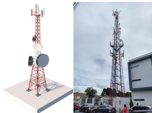
Figura 1.7. Estructura de Soporte – Torre Auto soportada
