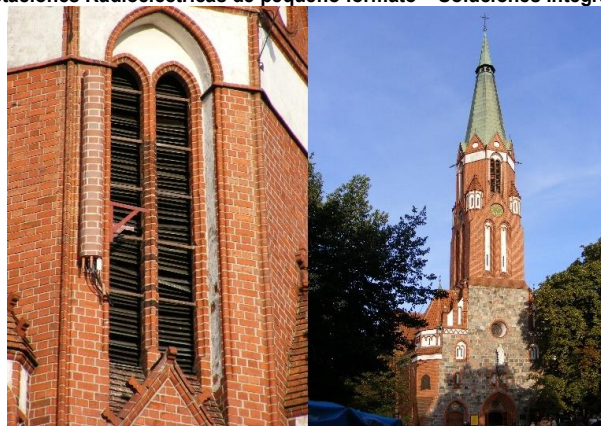
Figura 1.45 – Estaciones Radioeléctricas de pequeño formato – Soluciones Integradas a Fachadas
