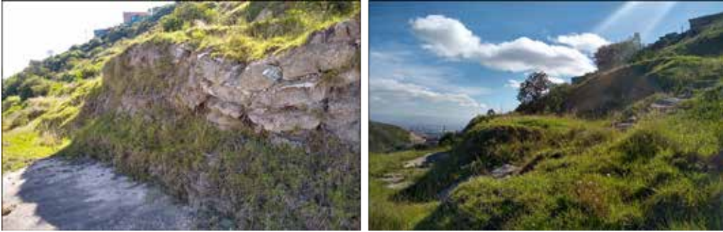
Fotografía 12. Vista en campo de explanaciones, terraceos y rellenos implementados sobre las laderas adyacentes al Drenaje 2 de la quebrada Limas
