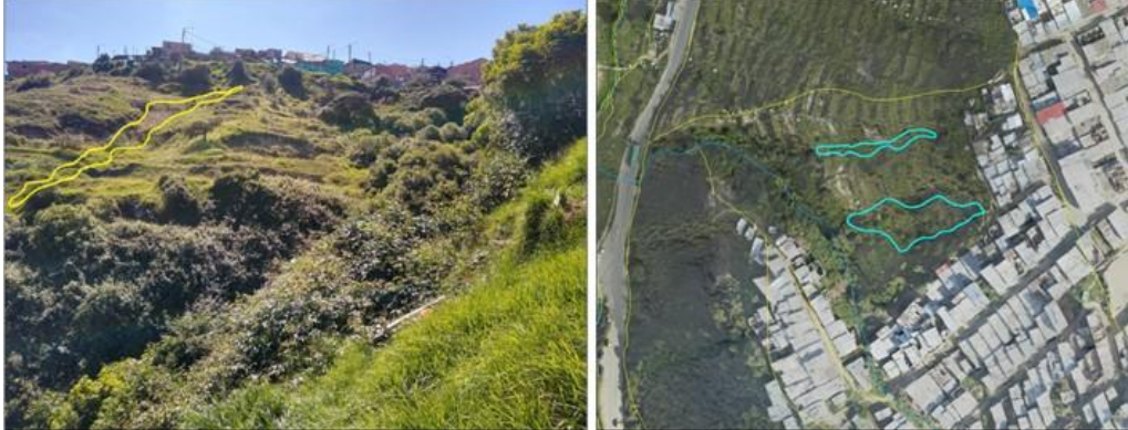
Imagen 35. Vista en campo y en planta sobre Ortomosaico de depósitos o conos coluviales (Dco)
