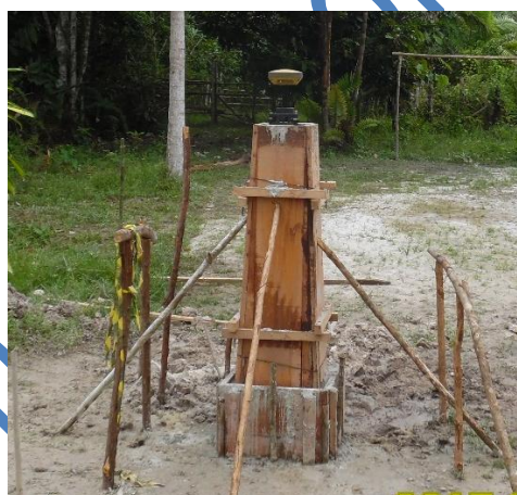
Figura 3. Encofrado para una monumentación tipo hito.
